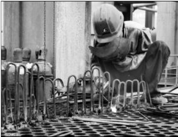
7 月 2 日,80 万吨氧化铝厂对蒸发Ⅱ组Ⅰ效计划性检修,将对 1050 根加热管束进行换新及部分过料管道的补漏。计划工期 28 天,图为施工现场。
